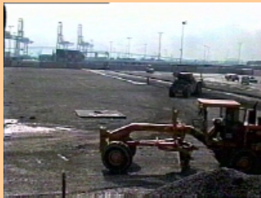
Area de construcción del sistema CRAM en el Puerto de Los Angeles enero 19 de 1993, mostrando la continuación de trabajos sin atraso alguno
