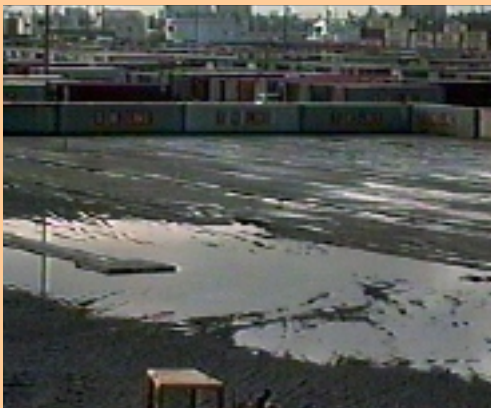
Area de construcción del sistema CRAM en el puerto de los Angeles enero 18 de 1993, después de 11 días de lluvias
