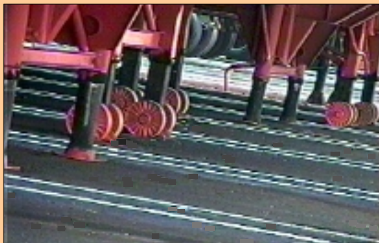
Pavimento CRAM en el Puerto de L.A. muelles 127-131, soportando cargo de los chasis.
