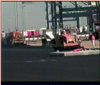
Pavimento CRAM , Puerto de L.A., muelles 127-131, construcción de la capa densa asfáltica construcción, usando 6 % contenido de asfalta.
